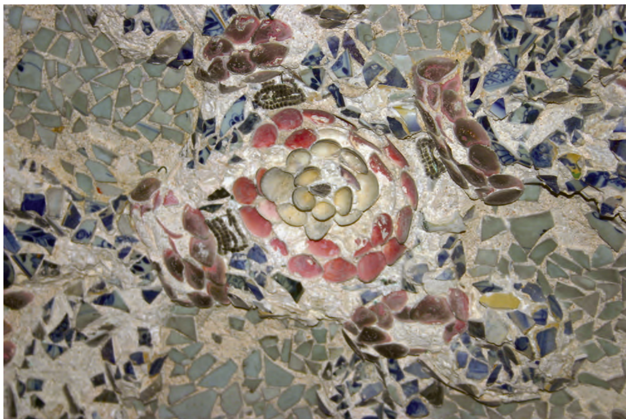
Fig. 3. Detalhe do embrechado da capela Santo Antônio da igreja da Boa Viagem. Foto da autora, 2012.
