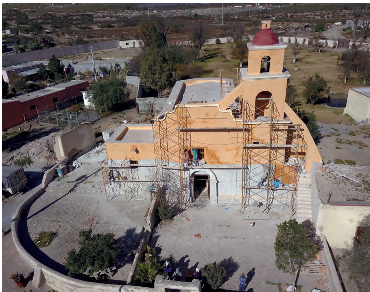
Fig 4. Proceso de intervención en la capilla de la Hacienda de Santa María. Ramos Arizpe. Coahuila. México.
